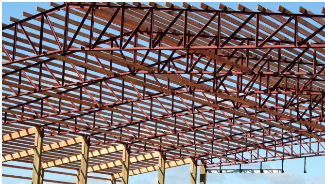
Cobertura em estrutura metálica
